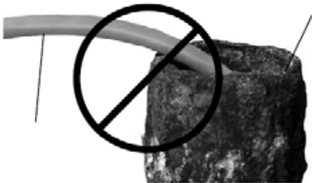
Abbildung 19: Nicht im spitzen Winkel ziehen
