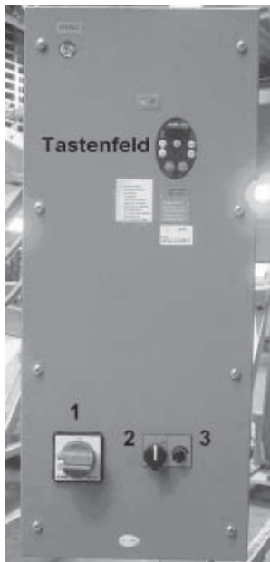
Abbildung 3: Frequenzumformer (FU)
